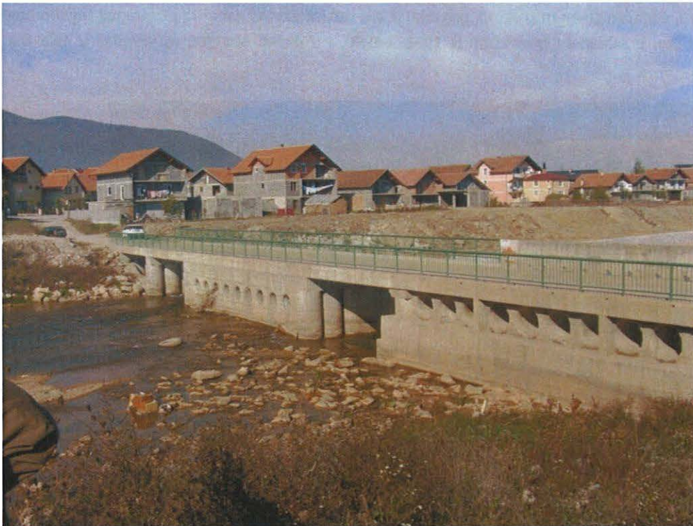
Slika 76. Pogled na ratni most sa uzvodne strane
